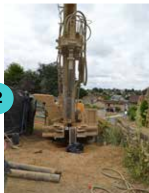
La foreuse creuse des trous tous les mètres dans lesquels sont insérés des pieux métalliques de soutènement
