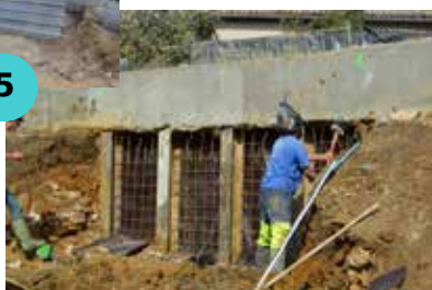
Pose de grilles entre les pieux et projection du béton
