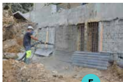
Pose de grilles entre les pieux et projection du béton
