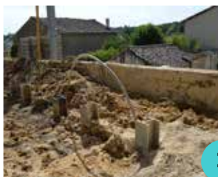
La foreuse creuse des trous tous les mètres dans lesquels sont insérés des pieux métalliques de soutènement
