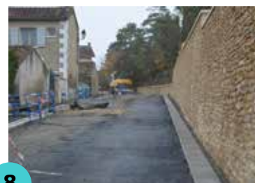
Mise en place du caniveau et du trottoir
