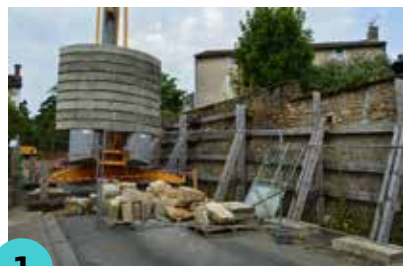
Installation d'une grue
