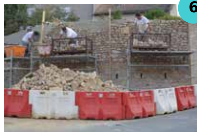
Pose des pierres de parement
