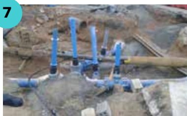
Raccordement des réseaux
