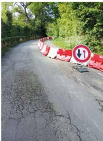
d'années, un mur de soutènement avait été créé. Ce mur étant lui-même posé à l'aplomb d'une falaise. Au fil des ans, le mur a fini par céder, il ne soutient plus ni la clôture, ni la route. Le bitume au-dessus tient miraculeusement comme en apesanteur. Il était donc urgent d'agir, c'est pourquoi la route a été mise en alternat.
